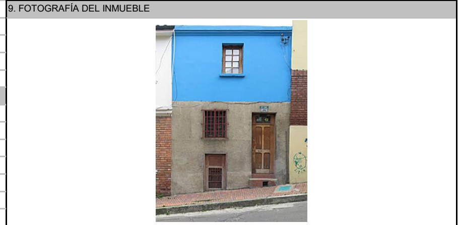
Fuente: Equipo Fotografía PEMP Patrimonio Inmueble
